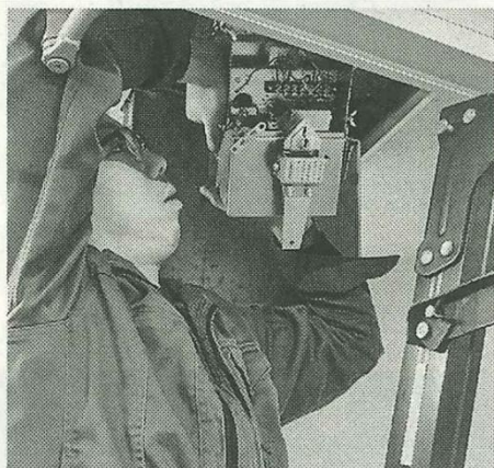
ダンパーメンテナンスの作業風景
